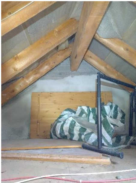
Abbildung 11 Detailansicht Dachboden Anbau Metzendorfvilla
